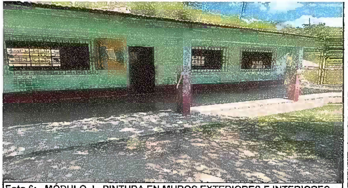
Foto 6: MÓDULO I. PINTURA EN MUROS EXTERIORES E INTERIORES
