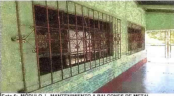
Foto 5: MÓDULO I. MANTENIMIENTO A BALCONES DE METAL
