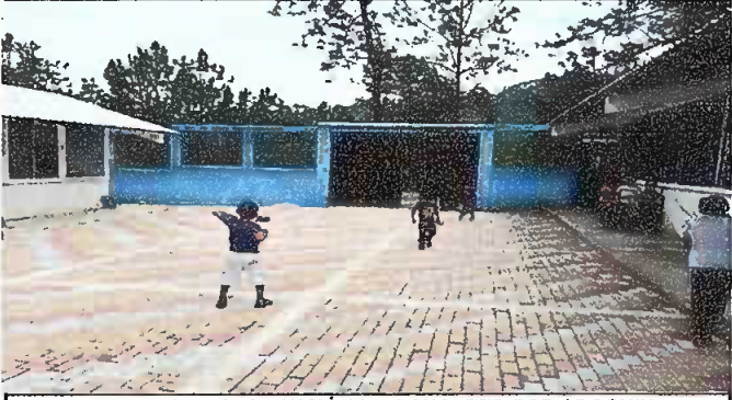
Foto 3: MODULO II: SUSTITUCIÓN DE CONCRETO POR ADOQUIN DECORATIVO
