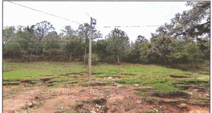
Foto 2: INSTALACIÓN DE ACOMETIDA ELECTRICA
