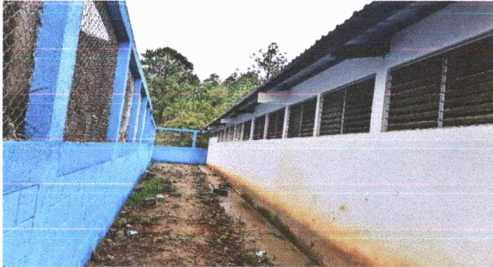
Foto1: SUMINISTRO E INSTALACION DE BALCONES DE HIERRO EN AREAS EXTERIORES
