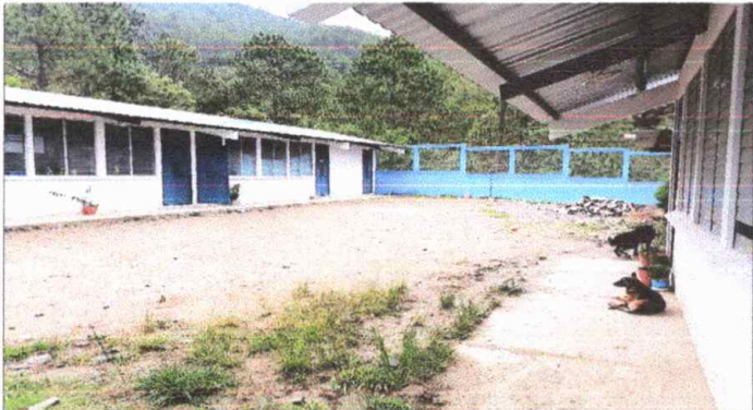
Foto 3: SUSTITUCIÓN DE CONCRETO POR ADOQUIN DECORATIVO
