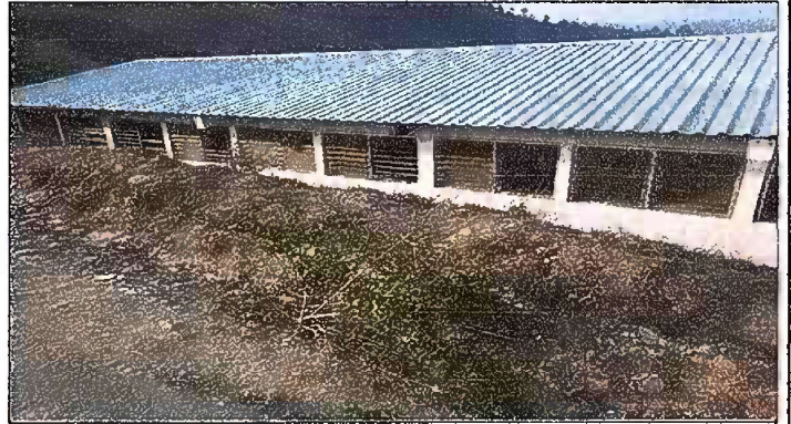
Foto 2: MÓDULO I. SUSTITUCIÓN DE VIDRIOS
