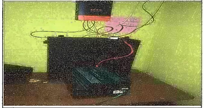
Foto 2: MODULO I: SUSTITUCIÓN DE BATERIA LITIO 200 AM
