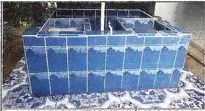
Foto 5: MODULO II: SUMINISTRO E INSTALACIÓN DE AZULEJO EN PILA
