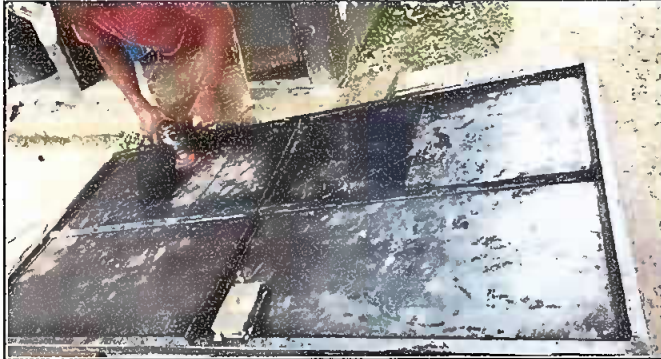
Foto 1: MODULO II: MANTENIMIENTO DE ESTRUCTURA DE PUERTA
