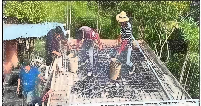
Foto 4: MODULO II: SUMINISTRO DE BASE DE CONCRETO PARA TINACO
