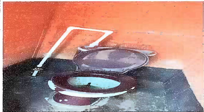
Foto 3: MODULO II: SUSTITUCIÓN DE INODOROS
