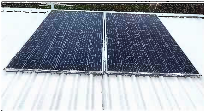
Foto 3: MODULO I: SUSTITUCIÓN DE PANEL SOLAR DE 440 WATS
