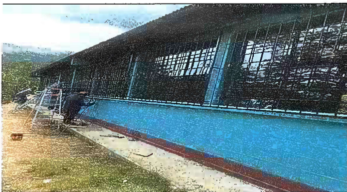
Foto 3: MÓDULO I. SUMINISTRO E INSTALACIÓN DE BALCONES DE METAL
