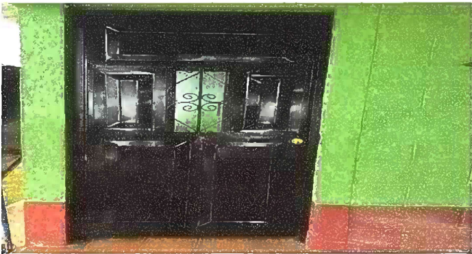
Foto 5: MÓDULO I. SUSTITUCIÓN DE PUERTA DE METAL
