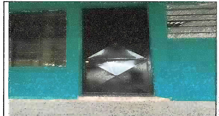
Foto 4: MÓDULO I. MANTENIMIENTO A ESTRUCTURA DE PUERTA (LIJADO, CEPILLADO, SUJECIONES, APLICACIÓN DE PINTURA)
