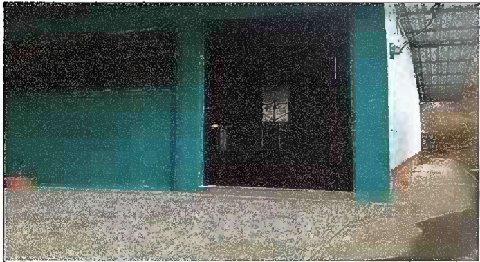
Foto 3: MÓDULO I. SUSTITUCIÓN E INSTALACIÓN DE PUERTA DE METAL
