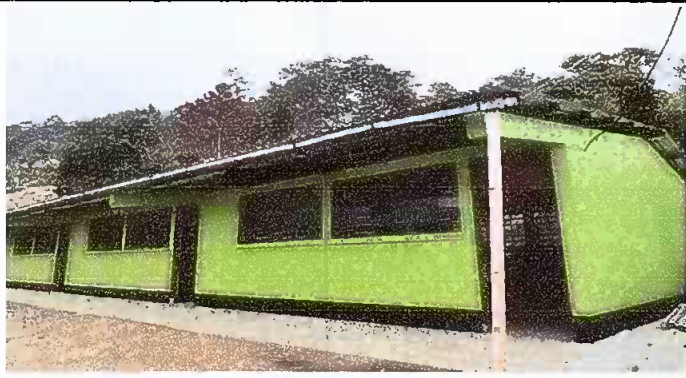
Foto 1: En esta fotografía se puede observar la finalización del pitado de la escuela.
