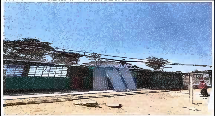
Foto 2: En esta fotografía se evidencia la colocación del techo.
