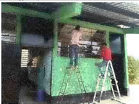
Foto 5: Sustitución de vidrios de las ventanas.
