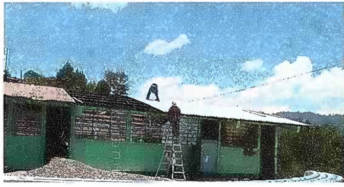
Foto1: Sustitución de lamina (techo de Aulas)
