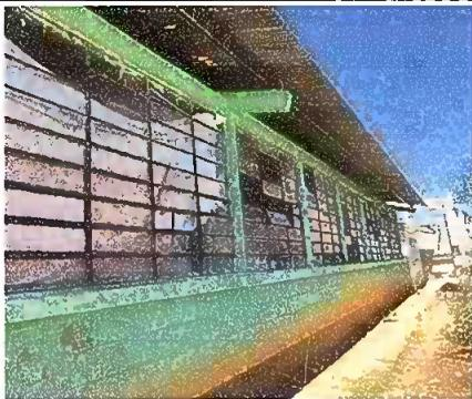
Foto 5: Sustitución de vidrios de las ventanas.
