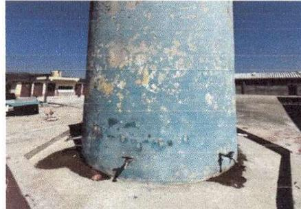
Foto 8: PINTURA DEL DEPOSITO DE AGUA, COMPLETAMENTE DETERIORADO.
