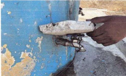
Foto 7: GRIFOS COMPLETAMENTE DAÑADOS CON FUGA PERMANENTE DE AGUA.
