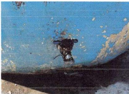
Foto 9: REPARACION DE GRIFOS EN MAL ESTADO DEL TANQUE DE AGUA.
