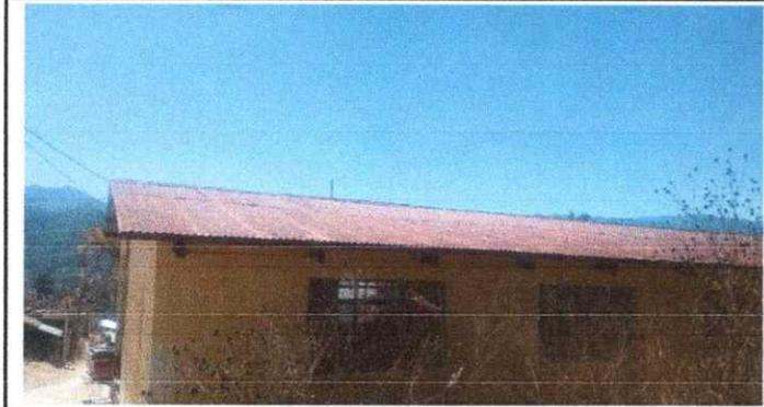
Foto 1: Sustrucción de Lamina, por Lamina Troquelada Aluzinc
