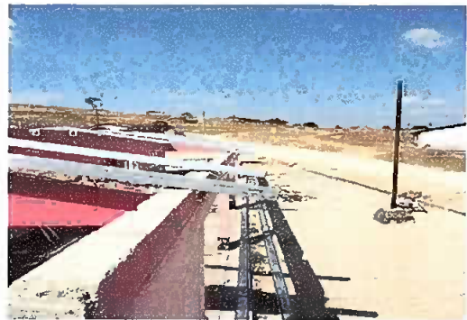
Foto 4: En proceso de colocacion de tubos cuadrados y costaneras a cambio de las vigas de madera.
