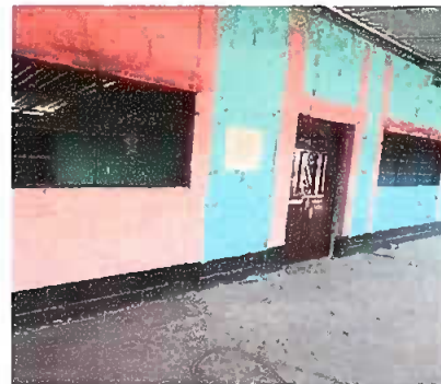
Foto 6: En proceso de cambio de pintura en la escuela
