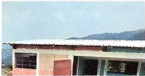
Foto1: En proceso de la colocacion del techo de lamina troquelada
