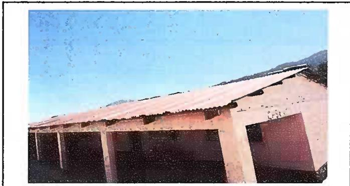
Foto1: Sustitucion del techo de lamina
