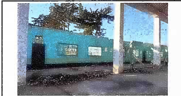
Foto 3: Sustitución de columnas de madera por concreto
