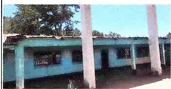
Foto 2: Sustituir el techado de aulas
