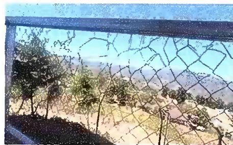
Foto 6: Sustitución de barandas
