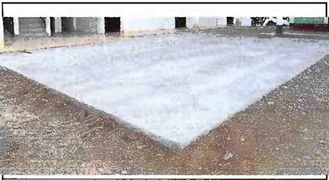
Foto 3: Reparación de planchas de concreto de patlo.
