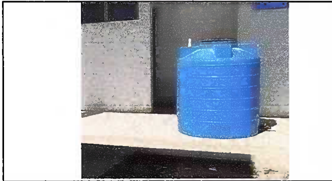
Foto1: Sustitución de depósito de agua 1700 Lt
