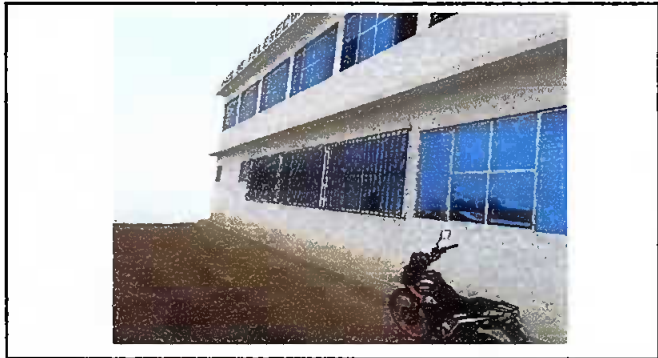
Foto 2: Sustitución de balcones de metal.
