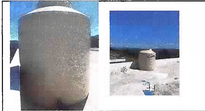
Foto1: Sustitución de depósito de agua 1700 Lt
