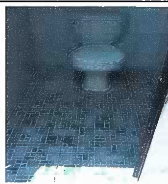
Foto 4: sustitución de piso de torta a piso ceramico antideslizante en los servicios sanitarios finalizado
