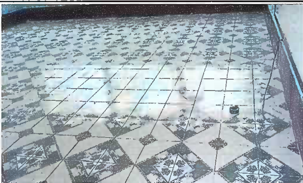
Foto 3: Sustitución de piso de torta a piso ceramico en el aula, bodega y direccion finalizado
