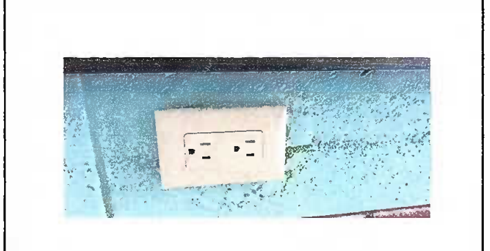
Foto 8: Sustitución de tomacorrientes de las lamparas tipo led finalizado
