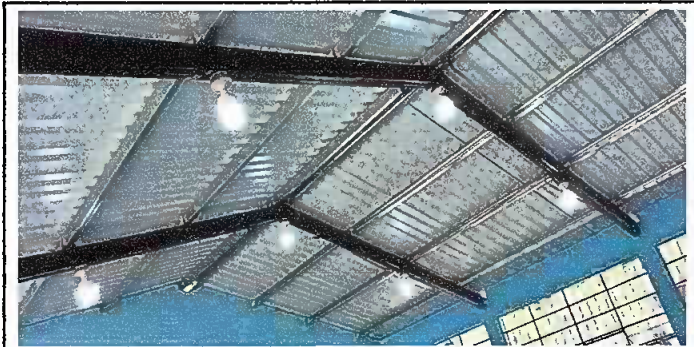
Foto 9: colocacion de luces tipo led en el aula finalizado
