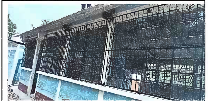
Foto 10: Elaboración e instalación de 8 balcones realizado/ finalizado
