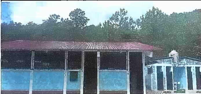
Foto1: Sustitución de lámina troquelada alucin calibre 26 finalizado
