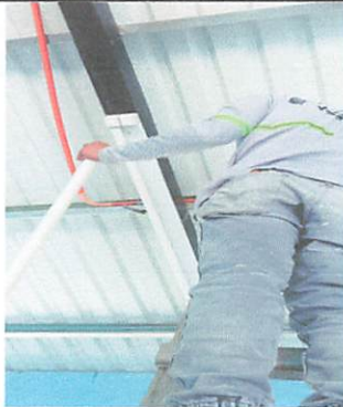
Foto 9: colocacion de luces tipo led en el aula
