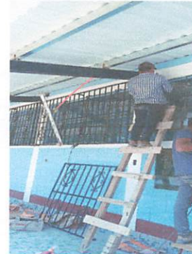
Foto 10: Elaboración e instalacion de 8 Balcones
