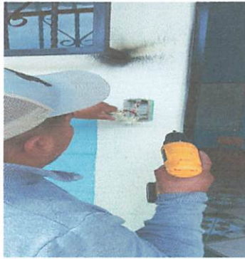
Foto 7: Sustución de interruptores de las lamparas tipo led
