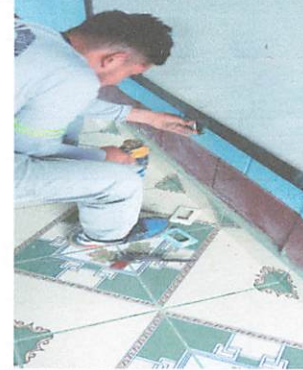
Foto 8: Sustución de tomacorrientes de las lamparas tipo led
