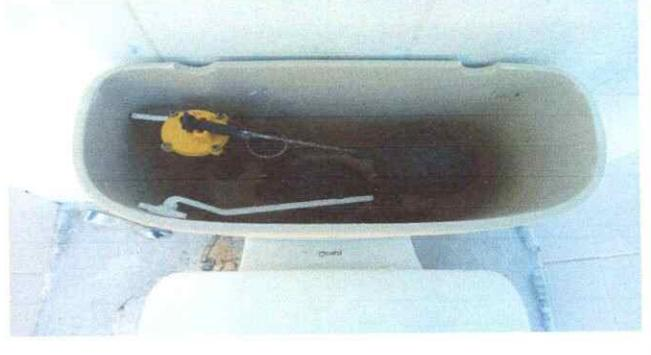
Foto 4: Cambio de accesorios, de tanques y tazas del servicio sanitario
