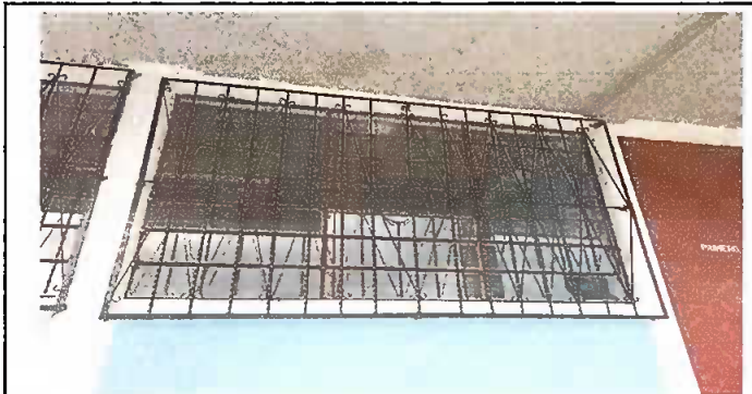
Foto 3: Balcones en ventanas
