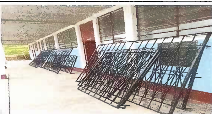
Foto 5: Colocacion de balcones en todas las ventanas
