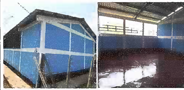
Foto 2: Sustitución de pintura en paredes exteriores e interiores, y mantenimiento de piso
