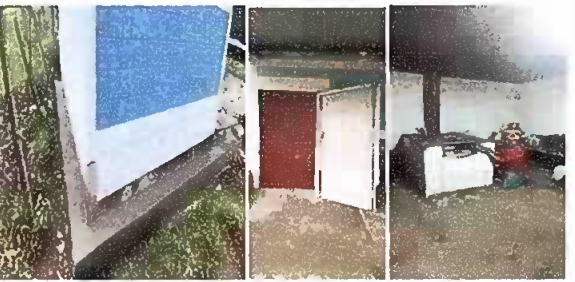
Foto 5: Sustitución de banqueta alrededor de la cocina por filtración de agua en la temporada de invierno, fabricación e instalación de 1 puerta y sustitución de 1 plancha.
