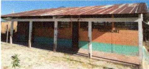
Foto 1: Sustrucción de laminas, por lámina troquelada aluzinc calibre 26
