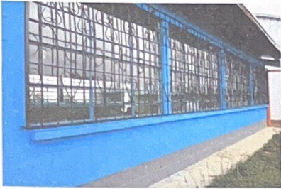
Foto 1: VISITA A ESCUELA REMOZADA
