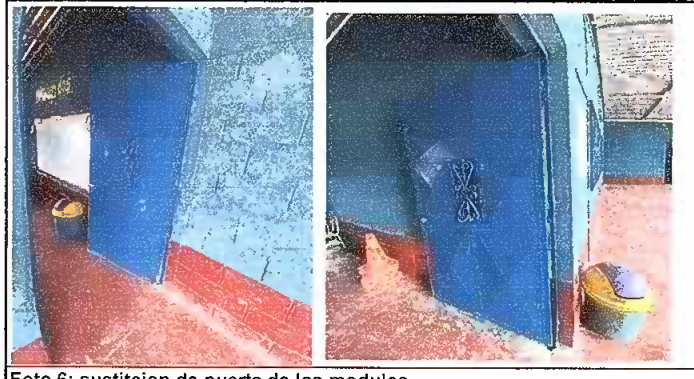
Foto 6: sustitcion de puerta de los modulos
