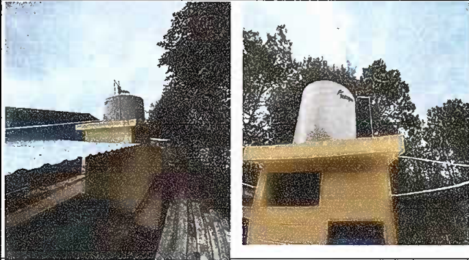
Foto1: sustitucion de deposito de agua de 1100 litro por uno de 1700 litro
