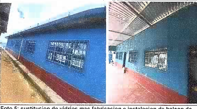
Foto 5: sustitucion de vidrios mas fabricacion e instalacion de balcon de metal
