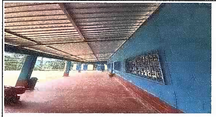
foto4: Sustitucion de estructura de soporte de madera, por metal y de elementos de fijacion
