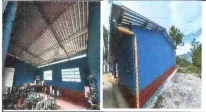
Foto2: Sustitución de lámina, por Lamina Troquelada aluzinc calibre 26
