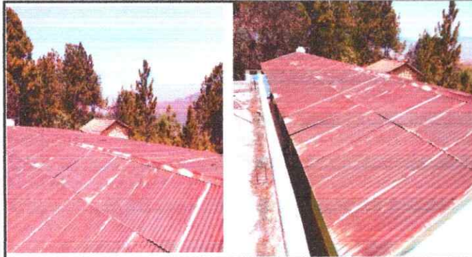
Foto3: Sustitución de capote de lámina para lámina troquelada
