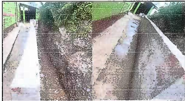
Foto 10: Reparación de cuneta de concreto.
