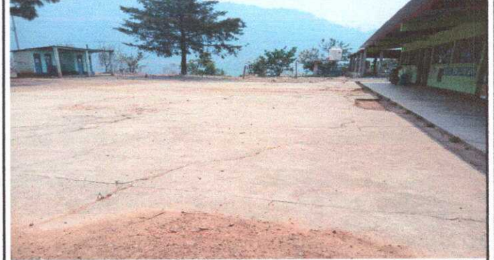
Patio: Sustitución de torta de concreto por adoquin decorativo
