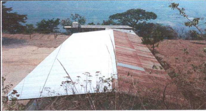
Modulo 1: Sustitución de lámina por lámina troquelada calibre 26
