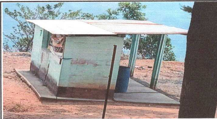
Modulo 2: Sustitución de lámina por lámina troquelada calibre 26
