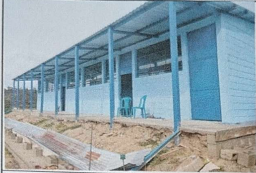
Foto 1: módulo 1 reparación de planchas concreto patio
