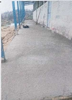
Foto 5: módulo 1 reparación planchas de concreto patio
