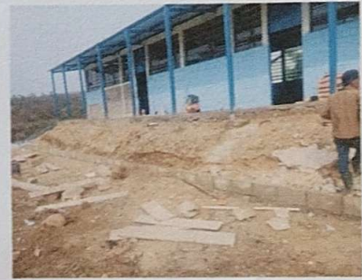
Foto 6: módulo 1 pintura de muros exteriores e interiores
