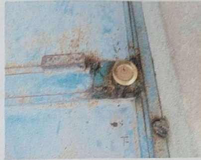
Foto 2: módulo 1 sustitución de chapas de puertas
