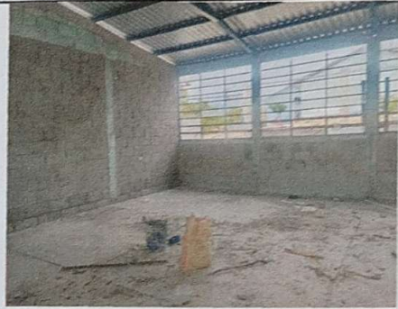
Foto 4: módulo 1 sustitución de lámina troquelada
