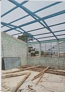
Foto 3: módulo 1 sustitución estructura soporte de techo
