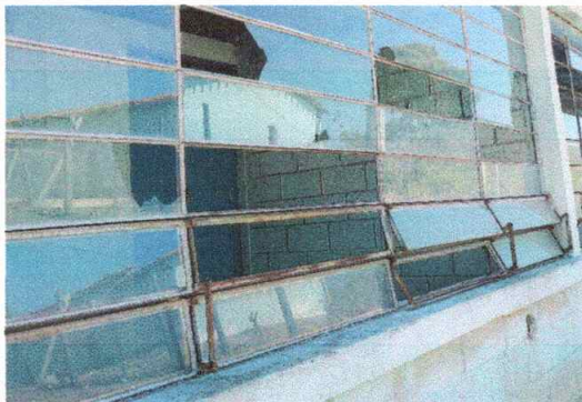
Foto 3: modulo 1: sustitucion de vidrios
