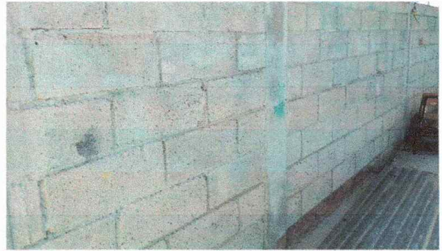
Foto 4: modulo 1: pintura en muros interiores y exteriores
