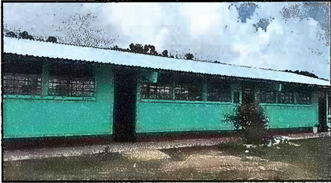
Foto1: Modulo 1 Cambio de láminas y mantenimientos de costaneras.
