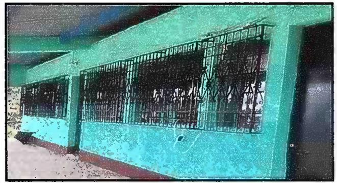
Foto 2: Modulo 2 Sustitución de vidrios e instalación de balcones
