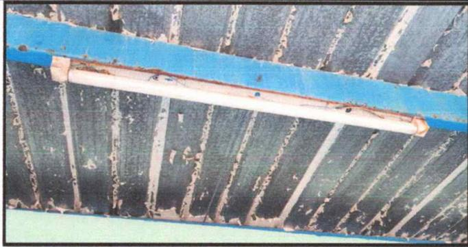
Foto 1 Modulo 1 Cambio de láminas y mantenimientos de costaneras.
