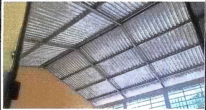
Estructura y lámina nueva instalada y finalizada con éxito
