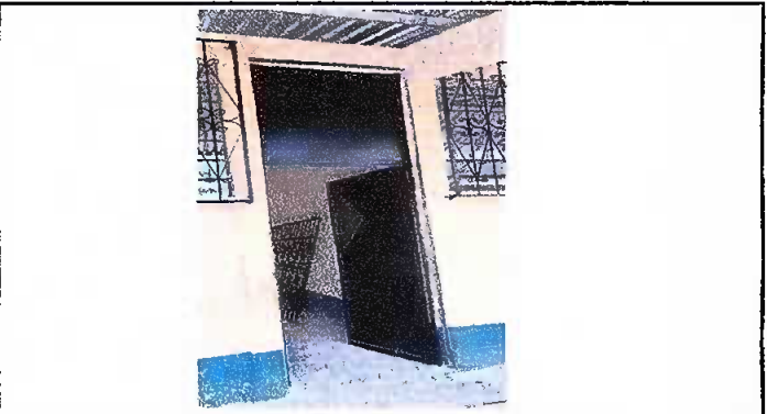
Puertas nuevas instalada. Proceso finalizado satisfactoriamente
