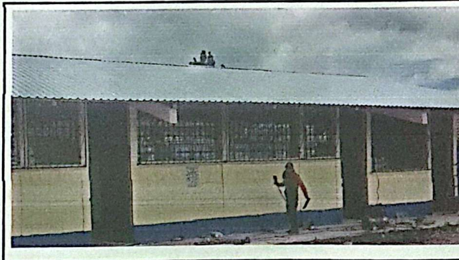
Suministro e instalación de balcón de metal.
