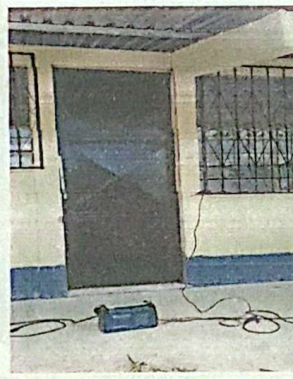
Sustitución e Instalación de puertas nuevas de metal
