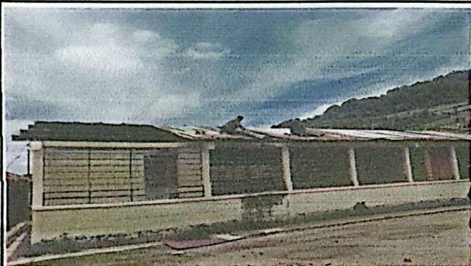
Desinstalación de lámina existente
