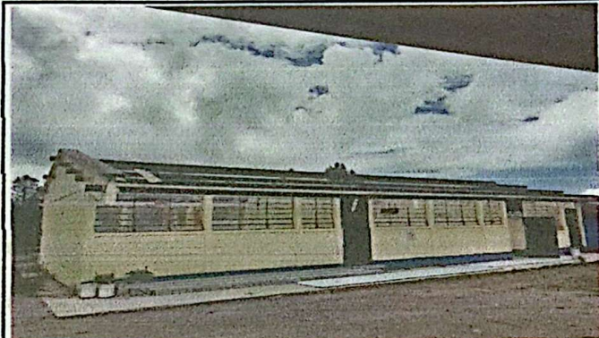
Desinstalación de Estructura de soporte de metal existente
