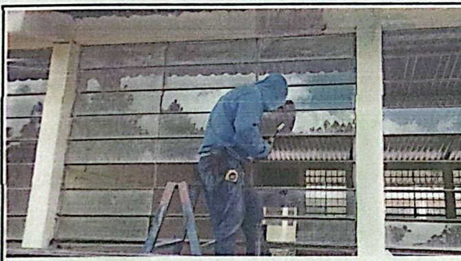
Limpieza y Sustitución de Vidrios.
