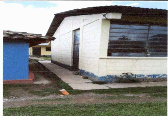
Foto 4: Sustitución de puertas de metal
