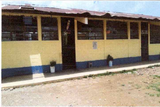
Foto 3: Sustitución de puertas de metal
