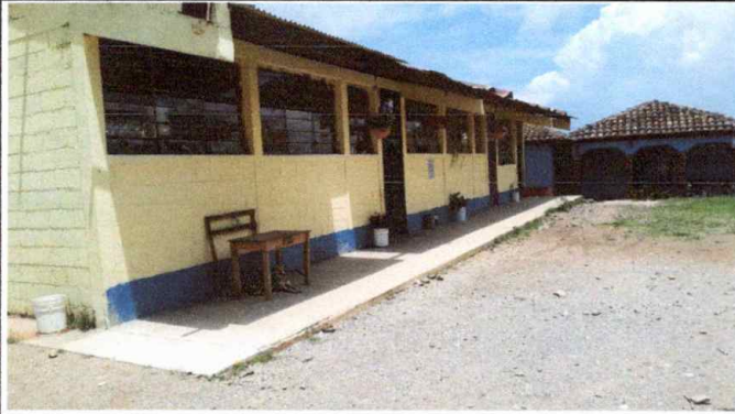
Foto 1: Suministro e instalación de balcón de metal
