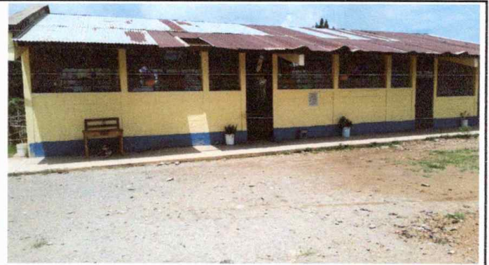
Foto 2: Sustitución de techo
