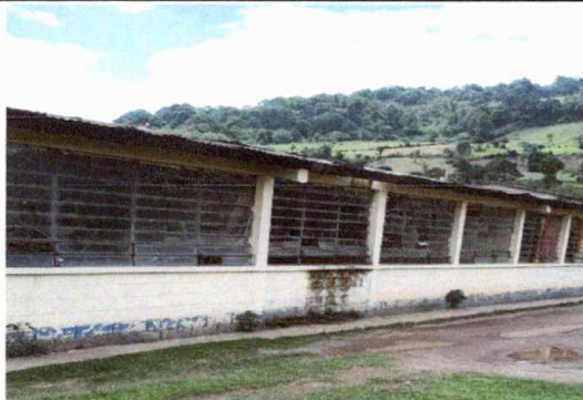
Foto 5: Sustitución de vidrios
