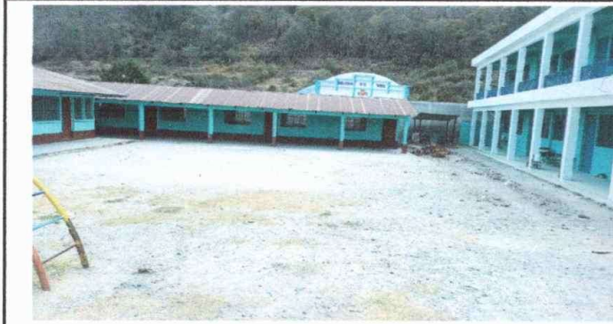
Módulo 1: Reparación de piso de torta de cemento
