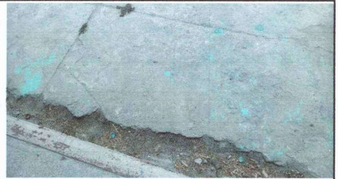
Módulo 2: Red de agua potable, sustitución de tubería línea principal
