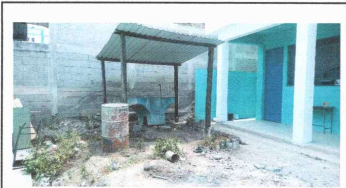
Módulo 3: Sustitución de pila de cemento de dos lavaderos, sustitución de lamina, sustitución de estructura de soporte
