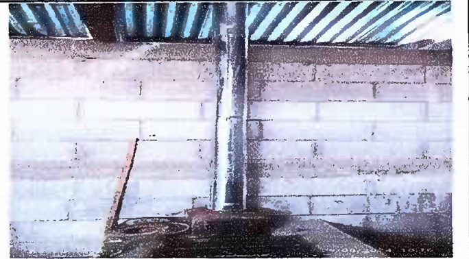
Foto 2: Mudulo 1: Sustitución de chimenea de metal.
