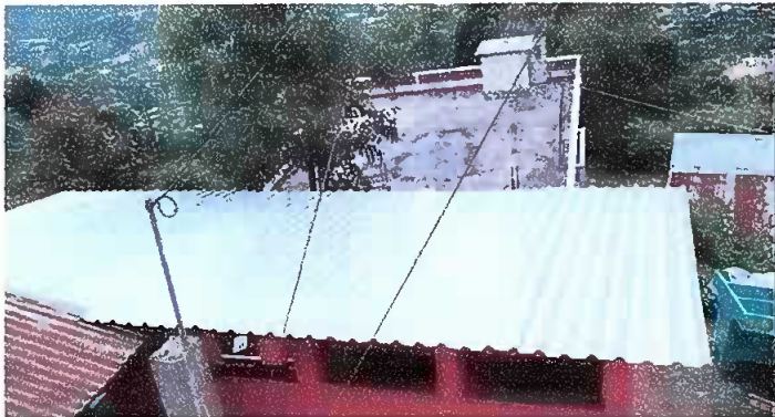
Foto 3: Modulo 2: Sustitución de lamina, por lamina troquelada aluzinc calibre 26.
