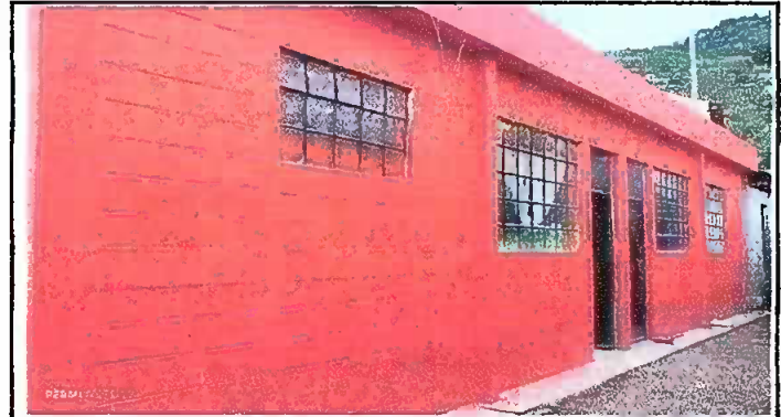
Foto 8: Pintura general : Pintura de muros interior y exterior.
