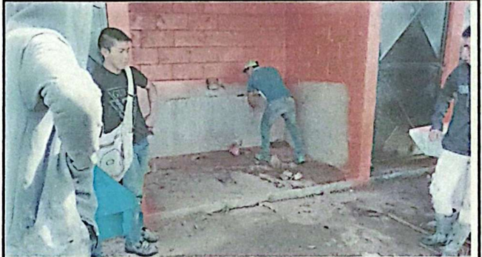
Foto 4: Modulo 2: Sustitución de pila de concreto dos lavaderos.
