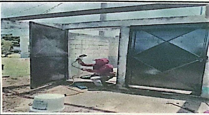
Foto 5: Modulo 2: Mantenimiento de estructura de puertas.
