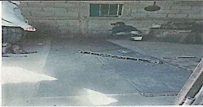
Foto 1: Modulo I : Sustitución de piso de torta de concreto por piso ceramico.
