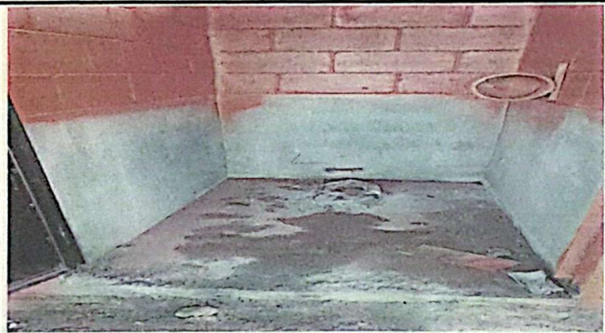
Foto 3: Modulo II: Sustitución de inodoros.
