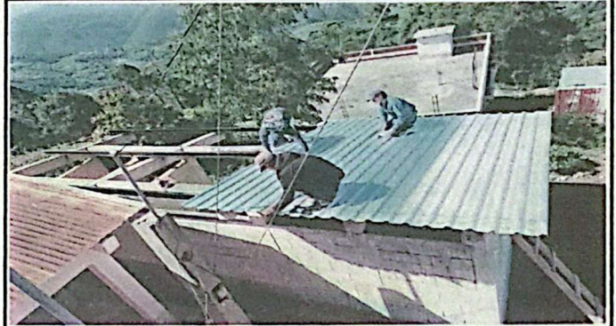
Foto 2: Modulo II: Sustitución de laminas, por lamina troquelada aluzinc calibre 26
