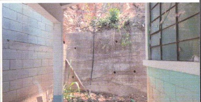
Foto 6: Muro Perimetral: Reparación de muro de contención
