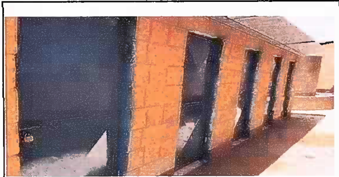
Foto 2 Módulo 1: Mantenimiento a estructura de puerta
