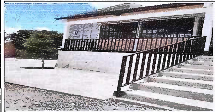
Foto 9 Módulo 6: Sustitución de balcón y barandas de metal
