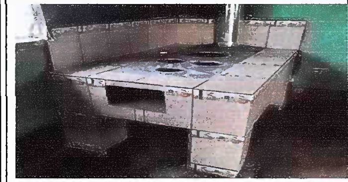
Foto 7 Módulo 4: Sustitución de estufa rural completa chimenea.
