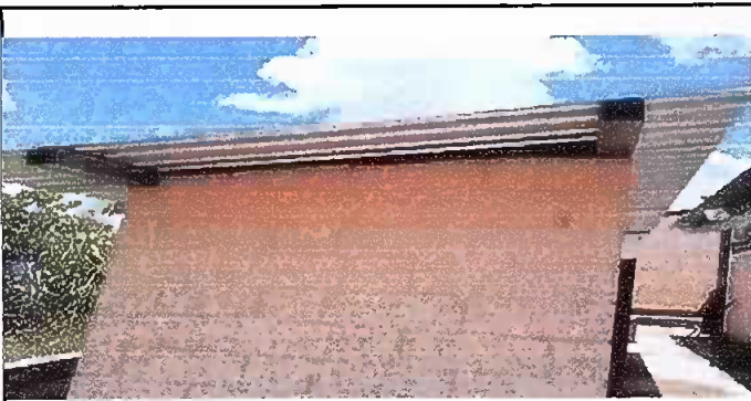
Foto 1 módulo 1: Sustrucción de estructura de soporte de madera por metal y cambio de lámina
