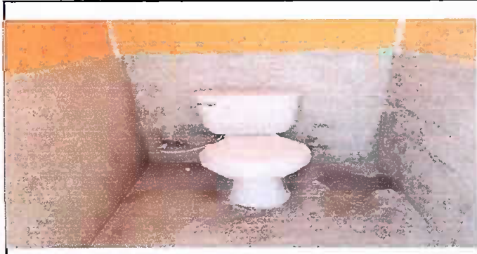
Foto 3 Módulo 1: Sustrucción de Inodoro
