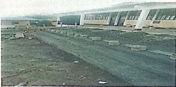
Foto 11 Módulo 6: Mantenimiento de gradas
