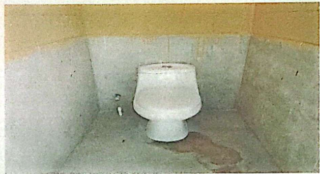
Foto 9 Módulo 5: Sustitución inodoro
