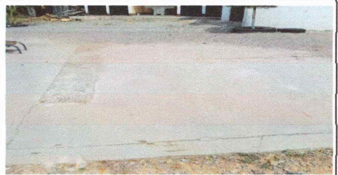
Foto 8 Módulo 3: Reparación de planchas de concreto de patio
