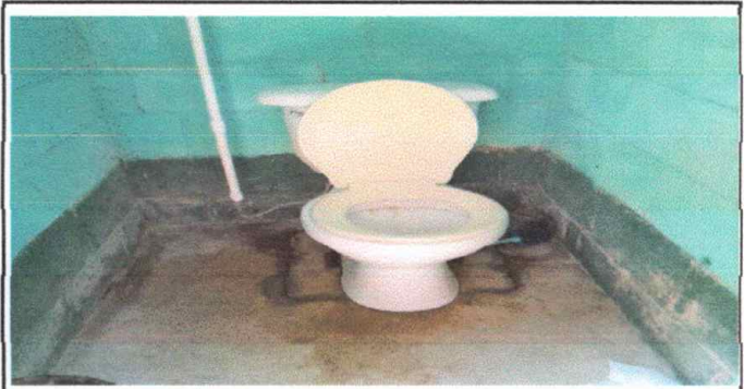
Foto 10 Módulo 5: Sustitución inodoro
