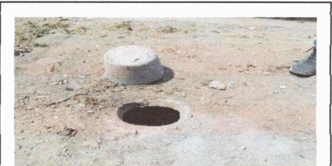
Foto 4 Módulo1 : Reparación de tapaderas de cajas
