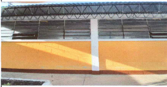
Foto 7 Módulo 2: Sustitución en suministro de balcones de metal.
