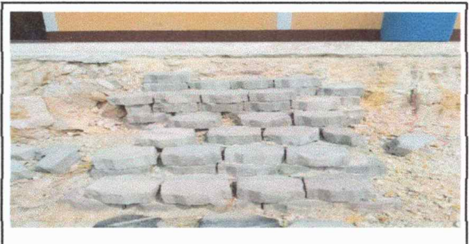
Foto 12 Módulo 6: Mantenimiento de gradas
