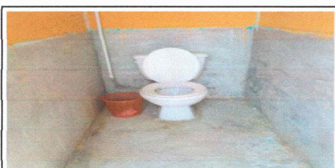
Foto 5 Módulo 1: Sustitución inodoro
