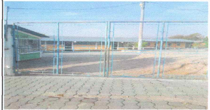
Foto 14 Módulo 7: Mantenimiento a porton de Metal.
