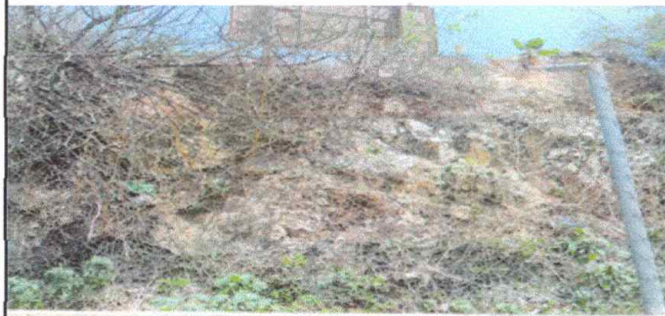
Foto 13 Módulo 7: Reparación de tubo hg y malla galvanizada
