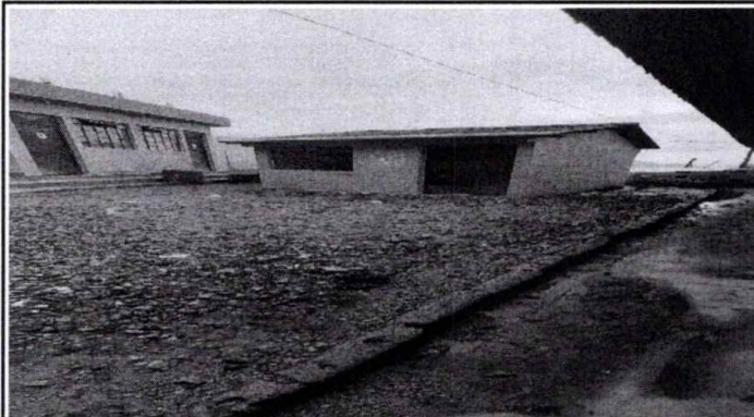
Foto 3: Patio, reparación de plancha de concreto.
