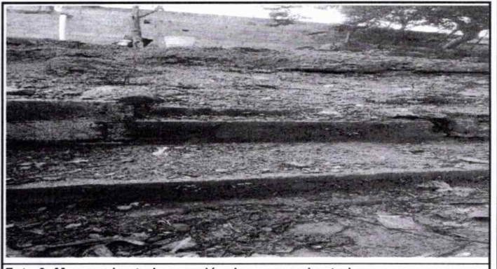
Foto 6: Muro perimetral, reparación de muro perimetral
